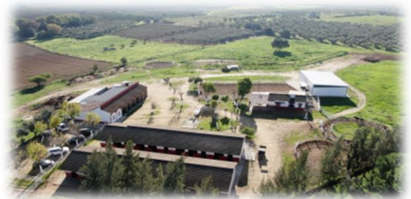
"Instalaciones Hípica Las Minas"
