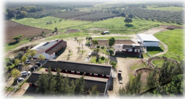
“Instalaciones Hípica Las Minas”
